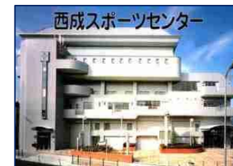
西成スポーツセンター 西成区岸里1-1-50
